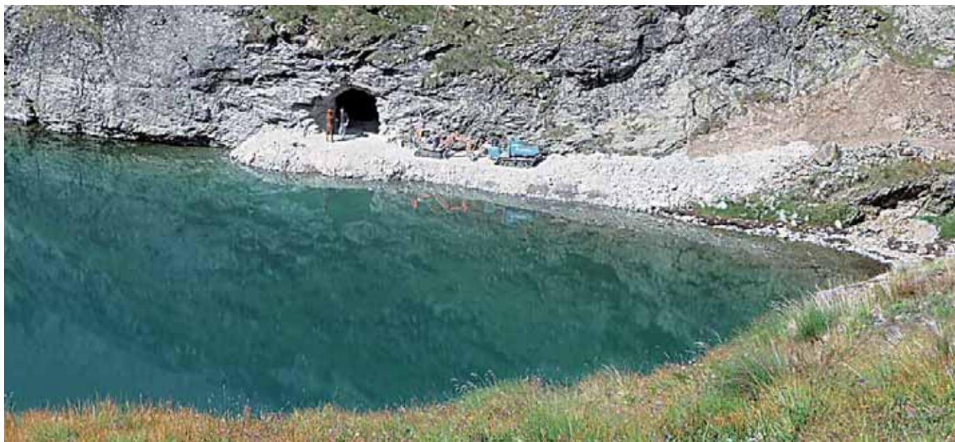
Fase iniziale dei lavori dell'opera di presa al Lago Laures inferiore (fine agosto 2010)
