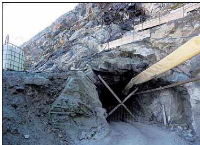
Imbocco a valle della galleria terminale (settembre 2010)
