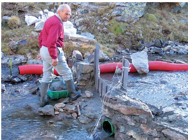
Al lavoro per la realizzazione dello stramazzo all'uscita del Lago Laures
