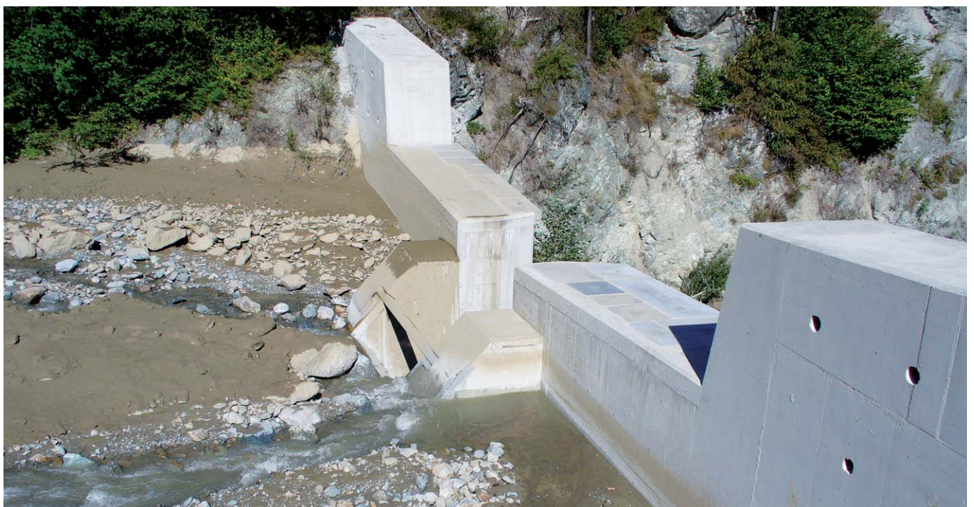
Il materiale trattenuto dalla briglia ha quasi raggiunto la sommità
