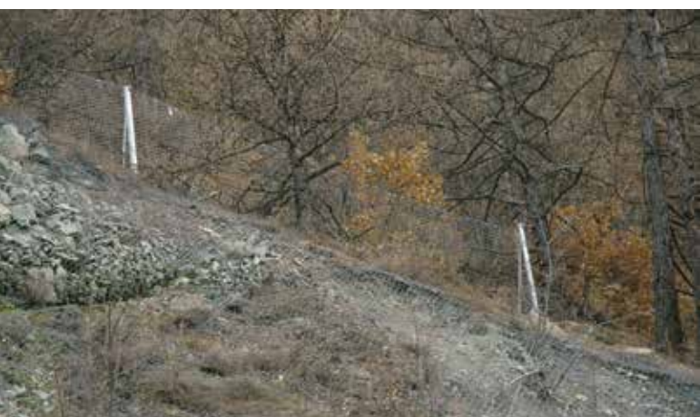
Particolare del nuovo paramassi a protezione della strada Grand-Brissogne – Pollein
