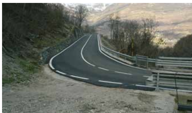
Allargamento strada regionale di Brissogne lato ponte sul torrente Laures
