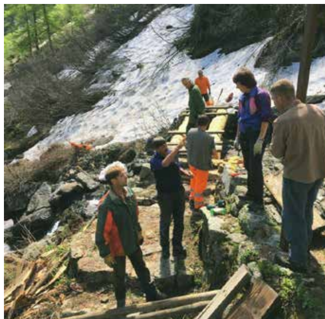
Ripristino del ponte che porta al Tramail
