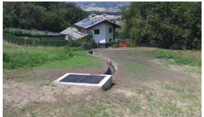
Sistemazione ru d'Établoz – dopo i lavori
