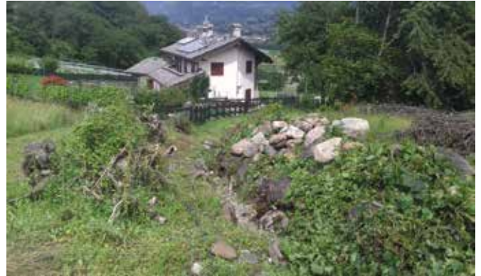
Sistemazione ru d'Établoz – prima dei lavori
