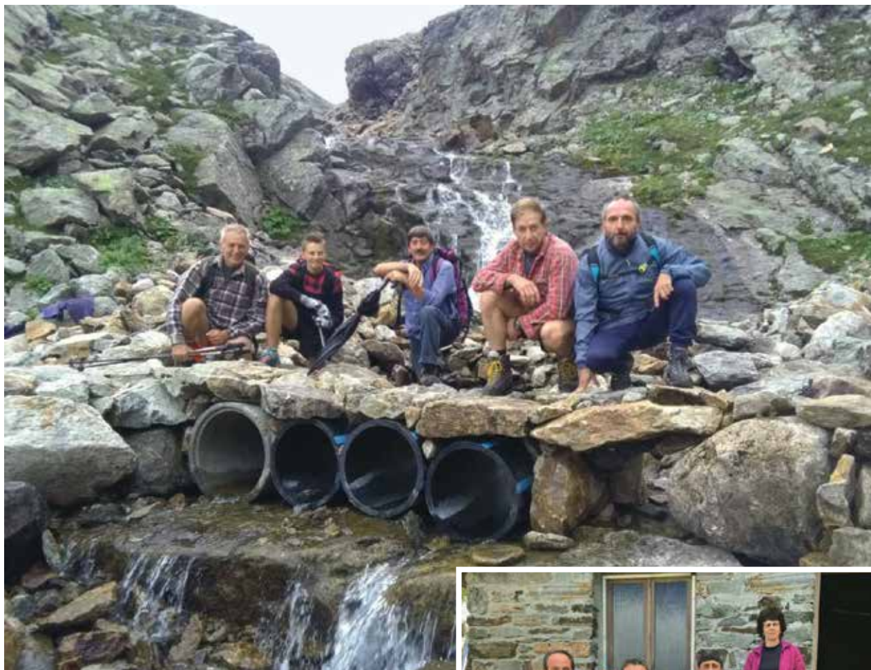
Lavori sul sentiero.
