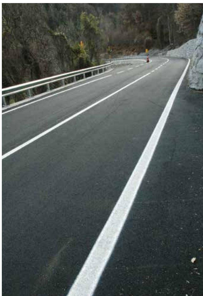
Allargamento strada regionale di Brissogne
