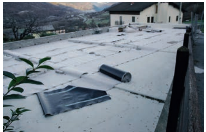
Lavori di manutenzione straordinaria autorimessa di Neyran in corso di realizzazione
