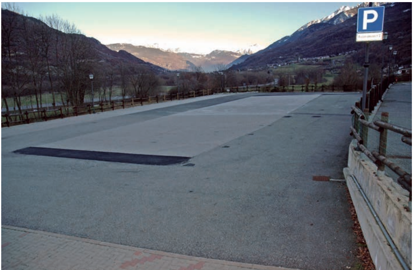
Piazzale Pâcou lato nord ripristinato
