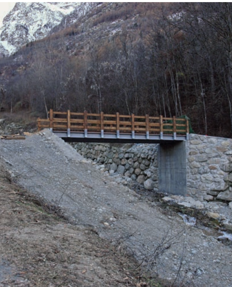
Ponte a monte della briglia di Vaud ricostruito
