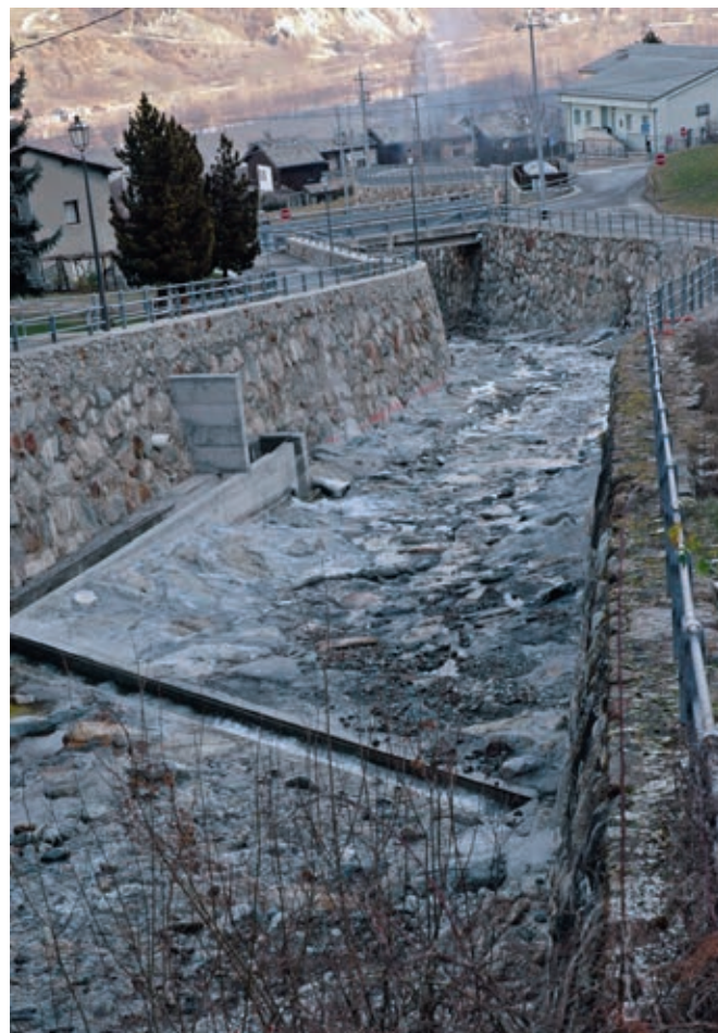
Lavori di sistemazione torrente Laures a Le Moulin
