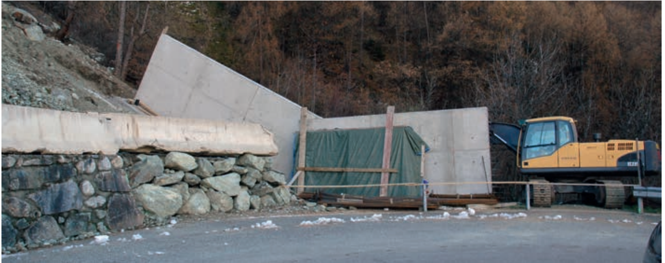
Paravalanghe a protezione della strada Ayettes-Chaney in corso di realizzazione
