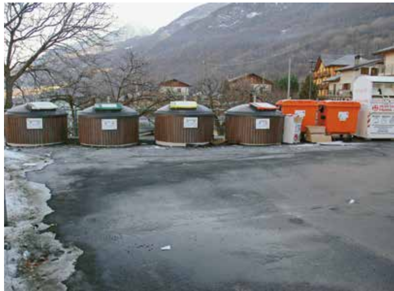
Il centro rifiuti interrati di Neyran
