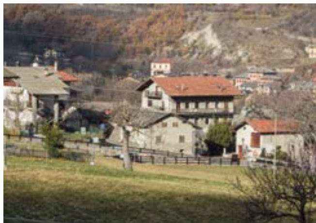
Veduta di Neyran-Dessous.
