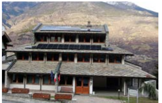
Impianto fotovoltaico installato sul tetto del Municipio.
