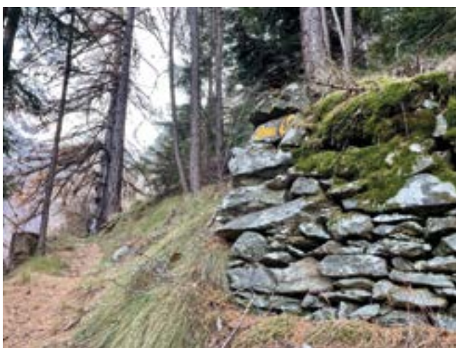
Muretto a secco con indicazione del sentiero.
