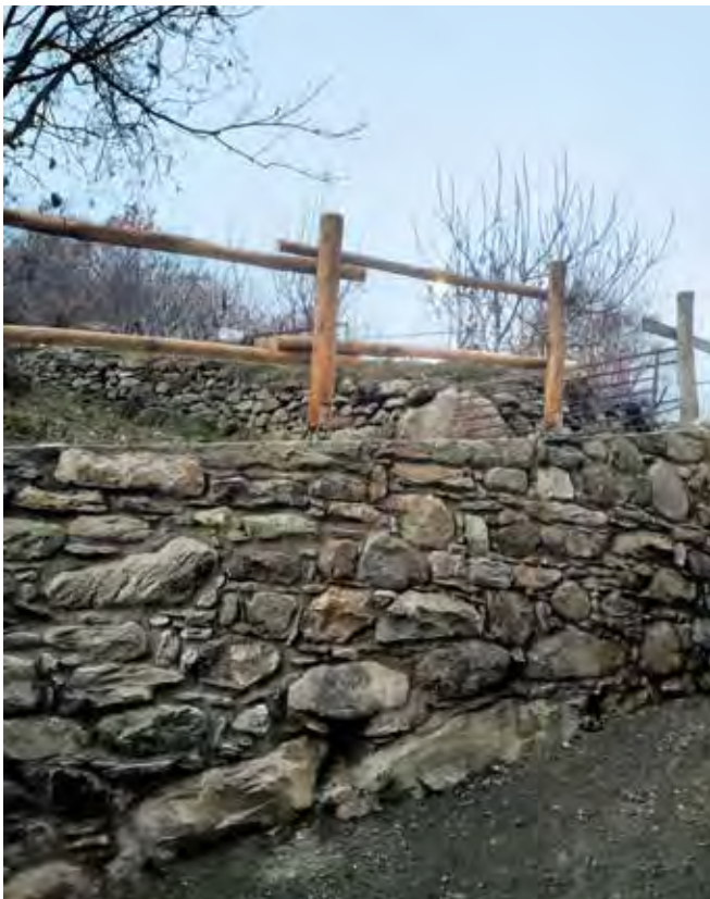
Muro ricostruito in frazione Le Pouyet.
