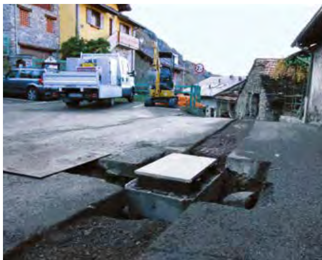
Nuovo pozzetto in costruzione.
