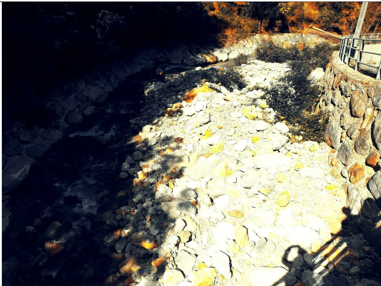
Deposito di materiale immediatamente a valle del ponte di Moulin
