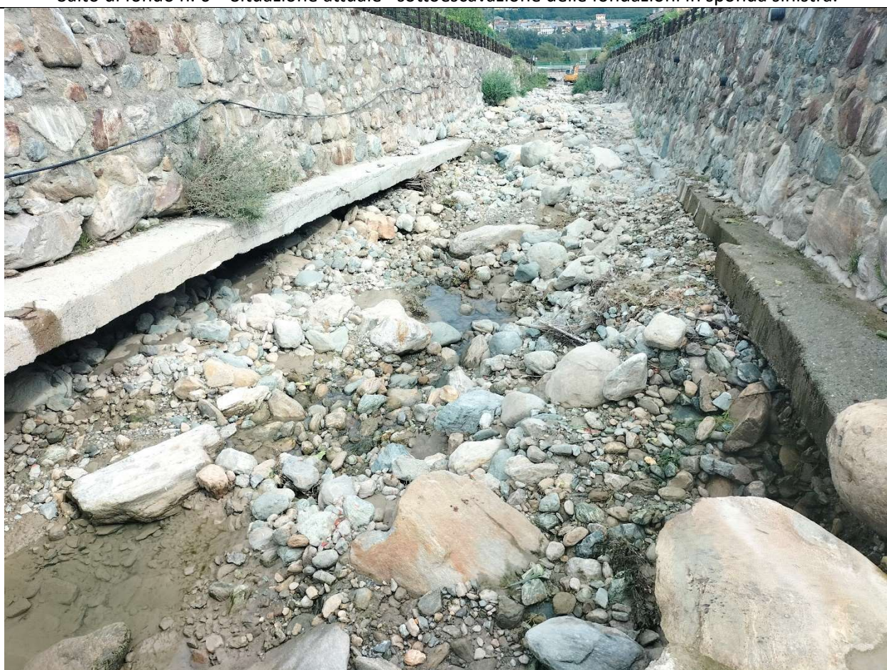
Salto di fondo n. 6 – Situazione attuale –veduta dal salto verso valle
