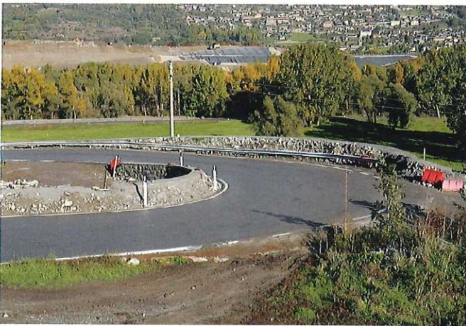
Particolare del tornante a valle di Pallu
