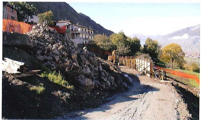
Il parcheggio in fase di costruzione
