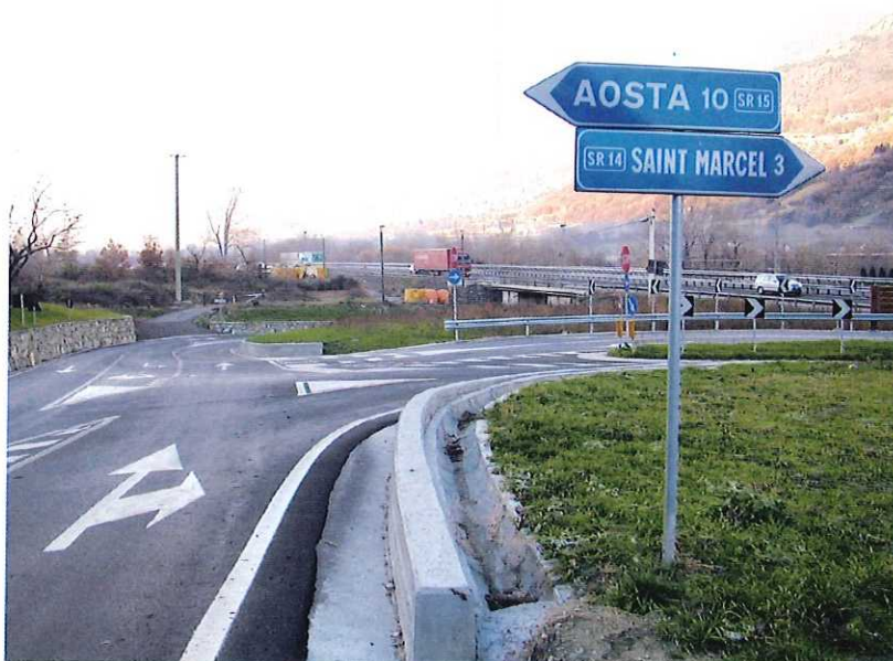
Lo svincolo del nuovo tratto della strada dell'Envers (lato Ovest)
