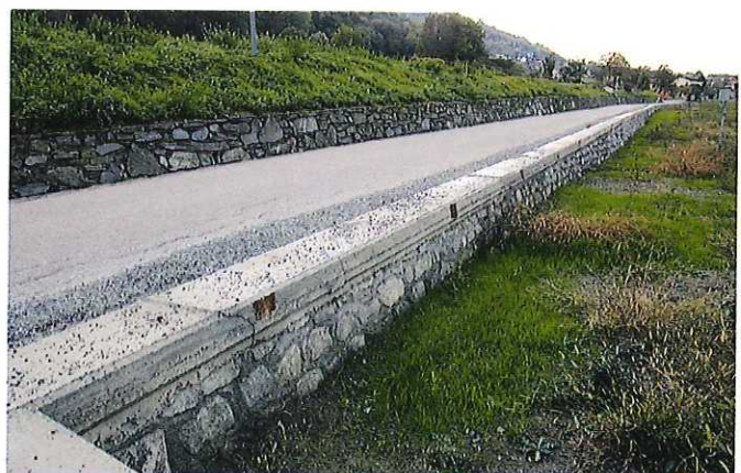
I nuovi muri di sostegno della strada
