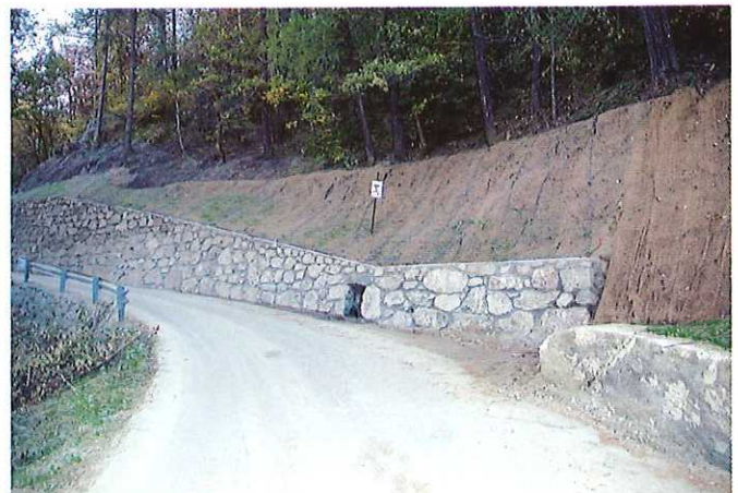
Muro di sostegno e sistemazione scarpate
