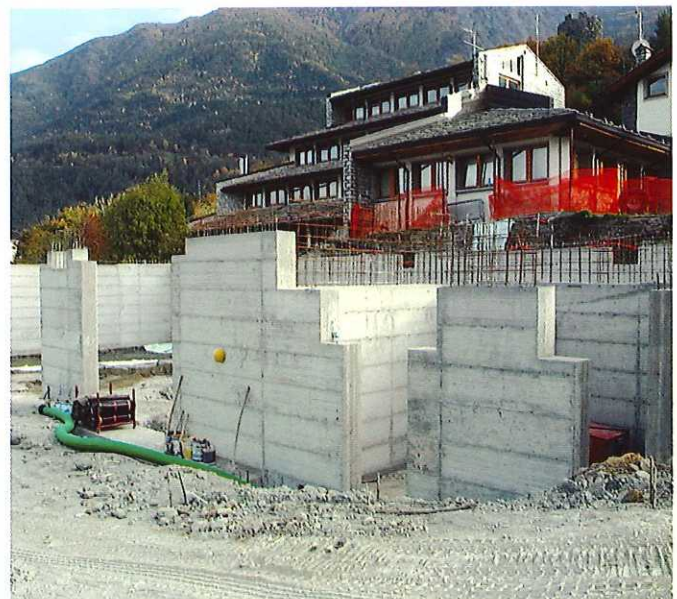
Il nuovo manufatto in fase di costruzione
