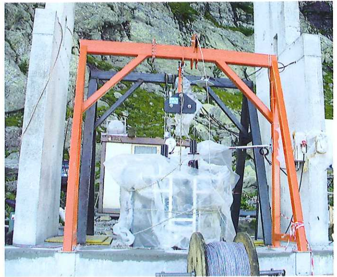
L'ascensore costruito per operare all'interno del fornello verticale
